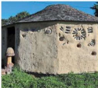
Les murs en terre paille de la yourte ont été réalisés par les bénévoles de l'association à l'automne 2021. | PHOTO : OUEST-FRANCE
